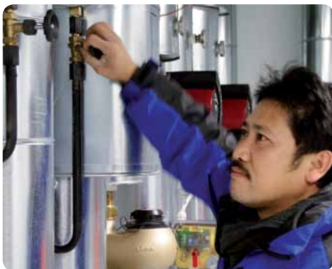
Hung Tran Van beim Einjustieren des Eisspeichers im Stuttgarter Stadtarchiv.
